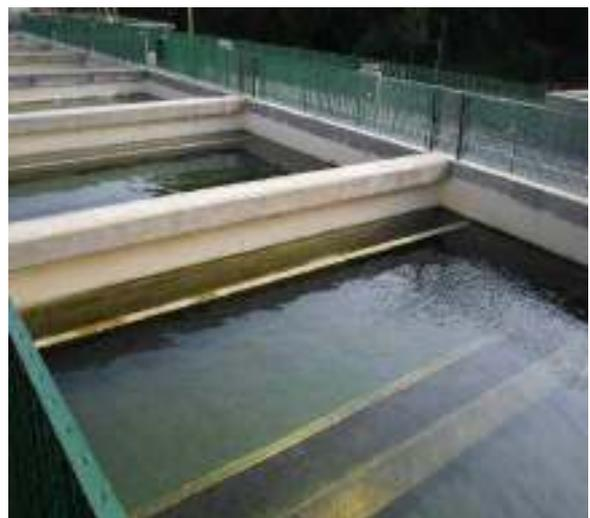
Una volta terminata la filtrazione, viene controllata la quantità di cloro residuo nell'acqua e si procede all'eventuale immissione di cloro in caso di necessità. L'acqua viene accumulata in due vasche interrato da cui, tramite l'utilizzo di pompe indipendenti, viene immessa in rete.
